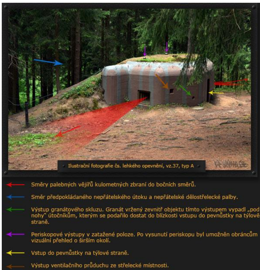
Obrázek 14 – vysvětlivky různých prvků na opevnění
