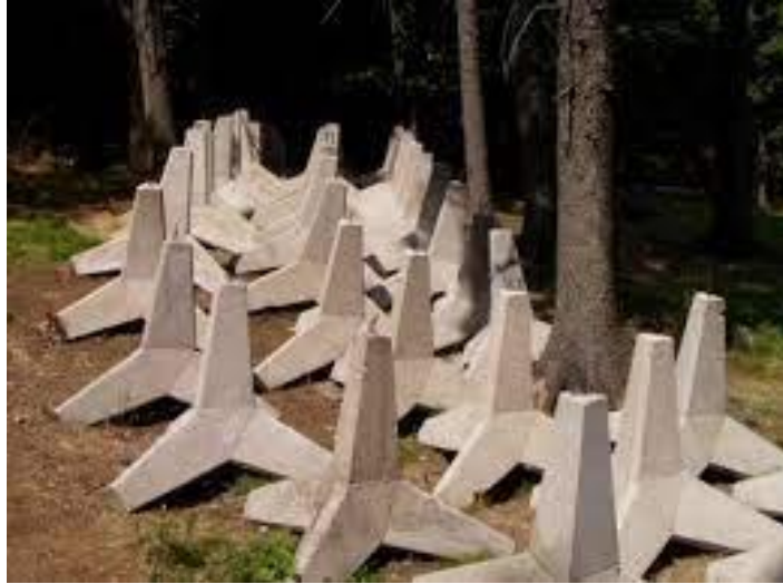
Obrázek 18 – železobetonví rozsocháči (ježci)
