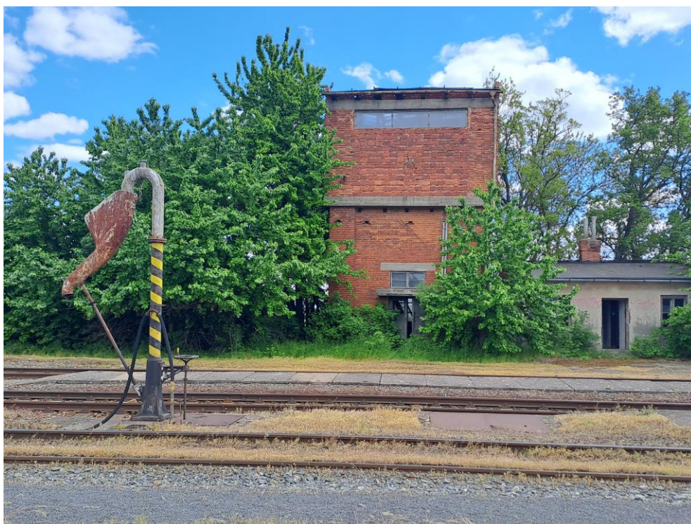
Obr.10 - Vodní věž na 15 m 3 vody, skladiště, vodní jeřáb – sloužil k napouštění vody do parních lokomotiv (zdroj: vlastní fotografie)
