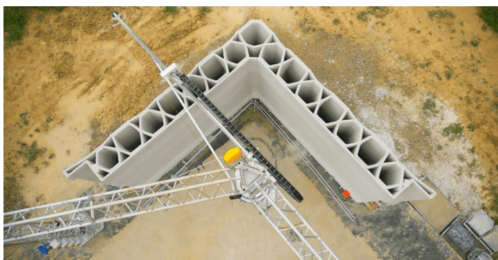
Obr. 8 Tisknutí domu Itaca
