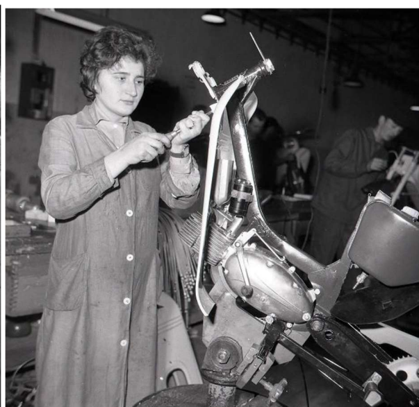
Obrázek č. 9 Výroba Jawy 50/05 (na snímku vlevo centrování kol) v Povážské Bystrici
